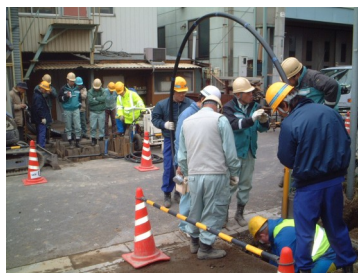
千葉県 7m道路横断部分の鉛給水管布設替状況。 路面本復旧費用を半面分節約。
