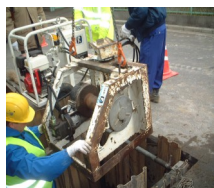
ウインチを約1m四方の 立坑の中に設置する。
