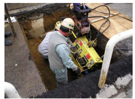
フレックスドリル施工状況②
