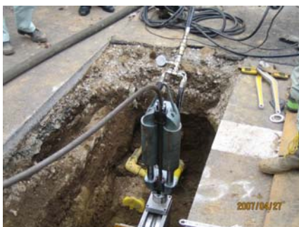
トリックトレンチレス設置状況
