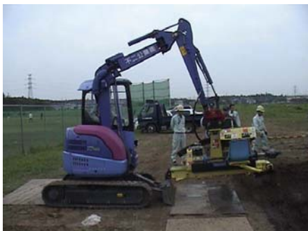
フレックスドリス接続状況
