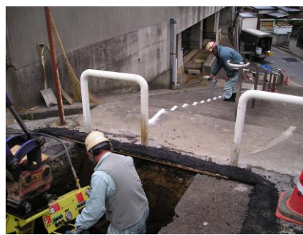
フレックスドリル施工状況①
