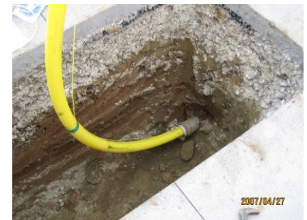
配管引抜き状況
