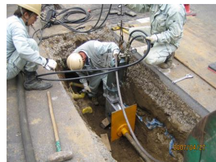
トリックトレンチレス施工状況
