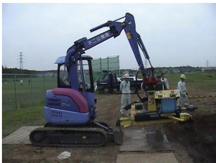
フレックスドリス接続状況
