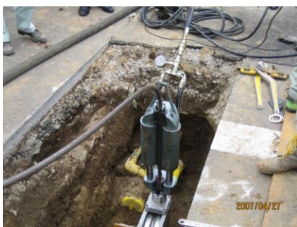
トリックトレンチレス設置状況
